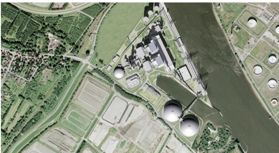
Das Kraftwerk Moorburg im Jahr 2012
